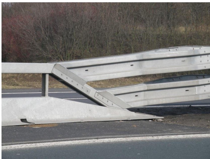
Obrázek 24 – Konstrukční požadavky na přechody přímým spojením
